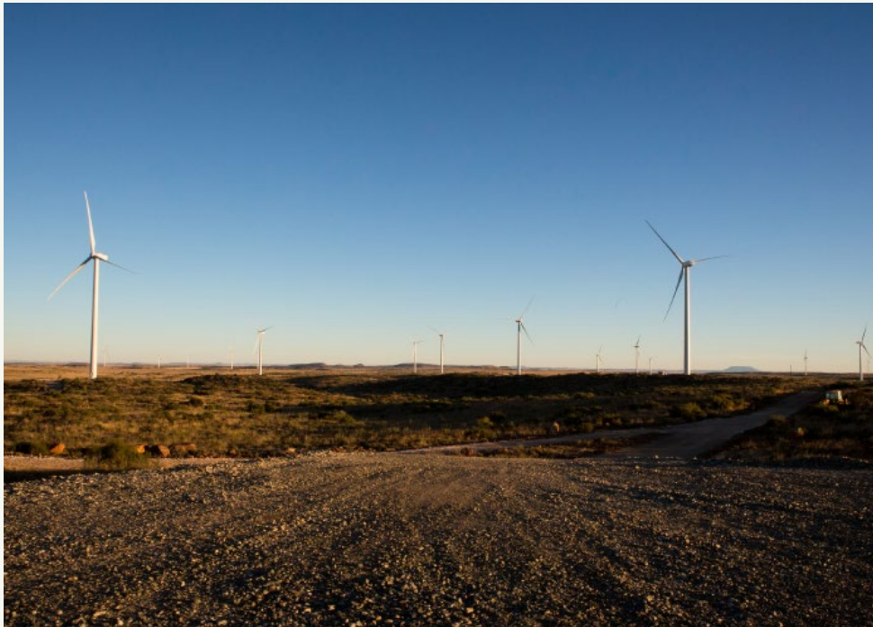
Windenergie in Südafrika
